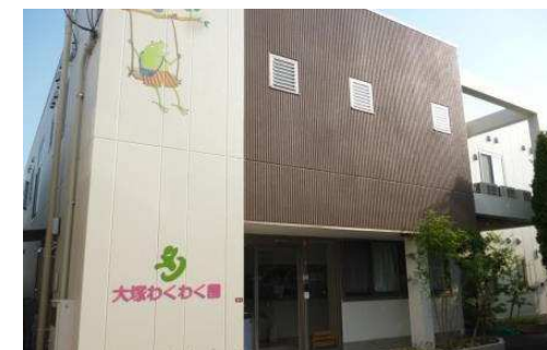
☆完成した大塚わくわく園 外観☆
